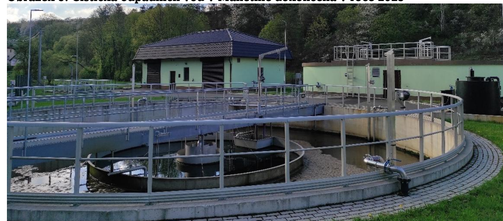
Obrázek 5: Čistička odpadních vod v Manětíně dokončená v roce 2023
